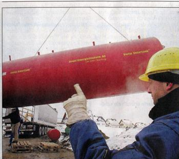
Kay Mine von der Firma Soli fer nahm den 7,30 Meter hohen Wasserspeicher für das Energetikhaus in Berthelsdorf mit in Empfang. Der Riesenspeicher fasst mehr als 28.000 Liter Wasser.
