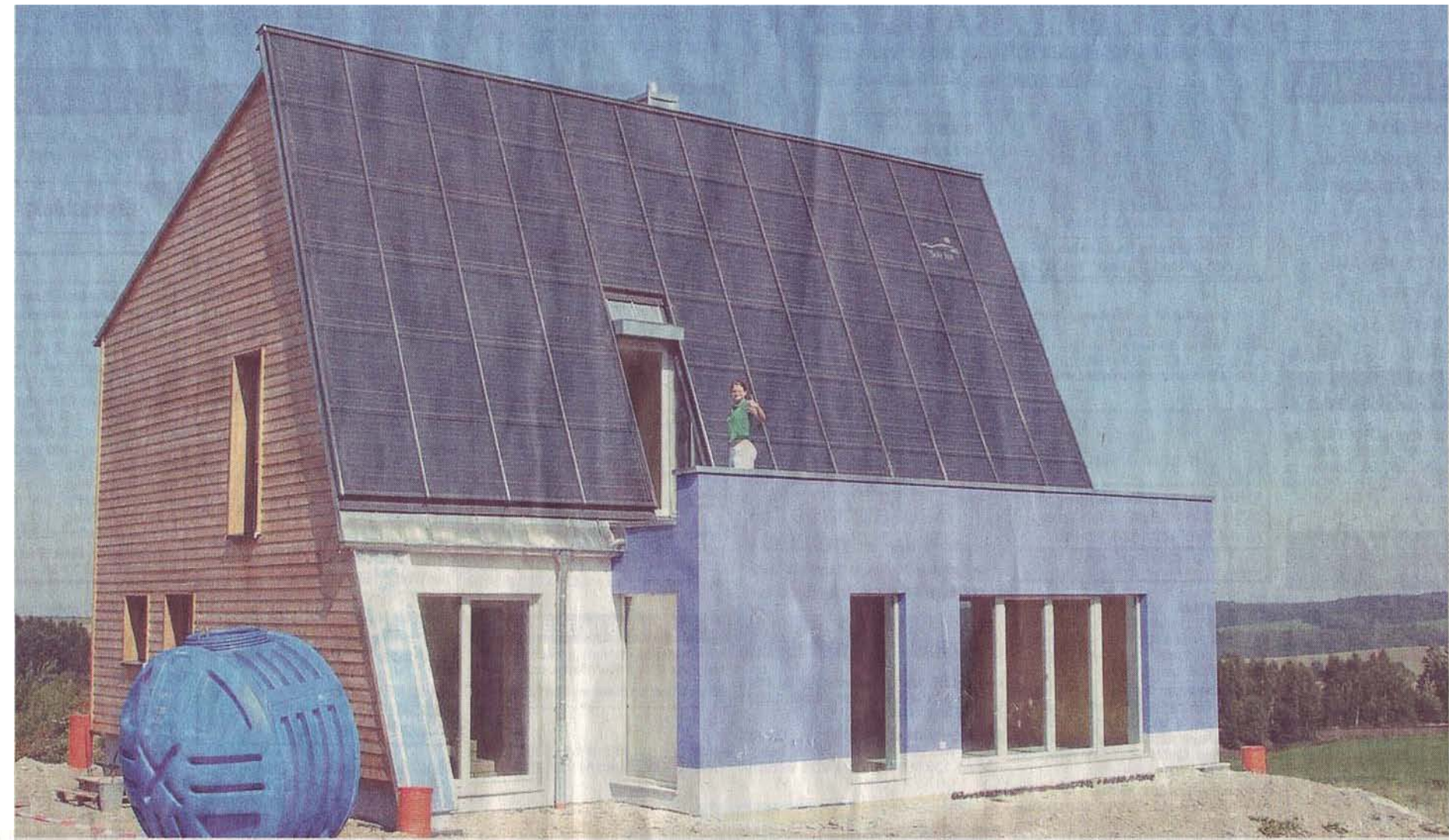
Das Energetikhaus 100 kann 95 Prozent der Energie für Heizung und Warmwasser aus der Sonne gewinnen.
